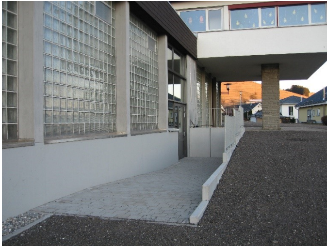
Neuer Fluchtweg an der Festhalle Leipferdingen
